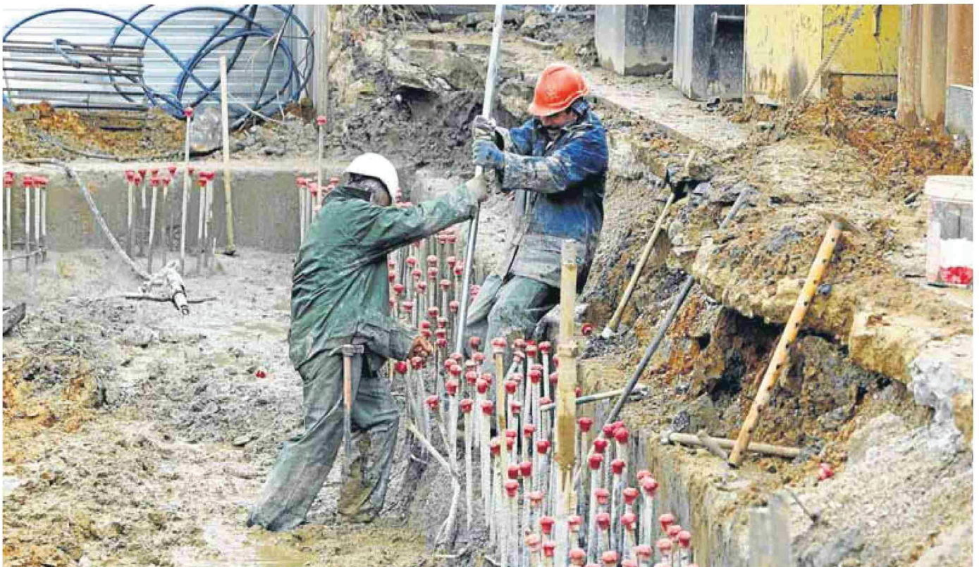
Trabajadores en una obra de pisos en Santander. ■ CELEDONIO
